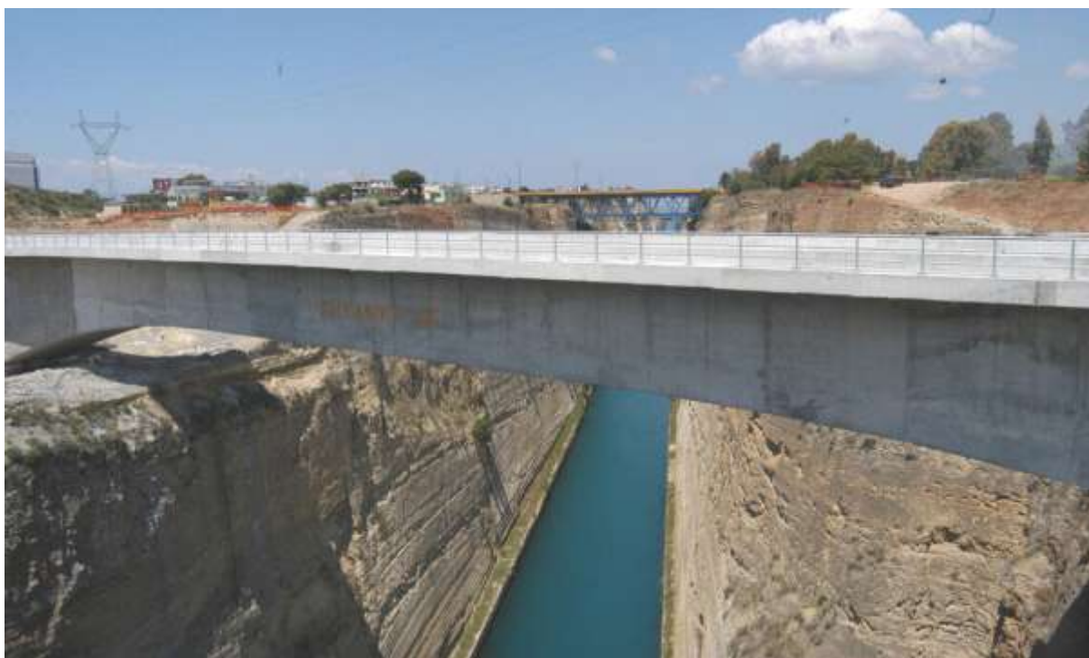
Σιδηροδρομική Γέφυρα Ισθμού: Ολοκλήρωση της κατασκευής
