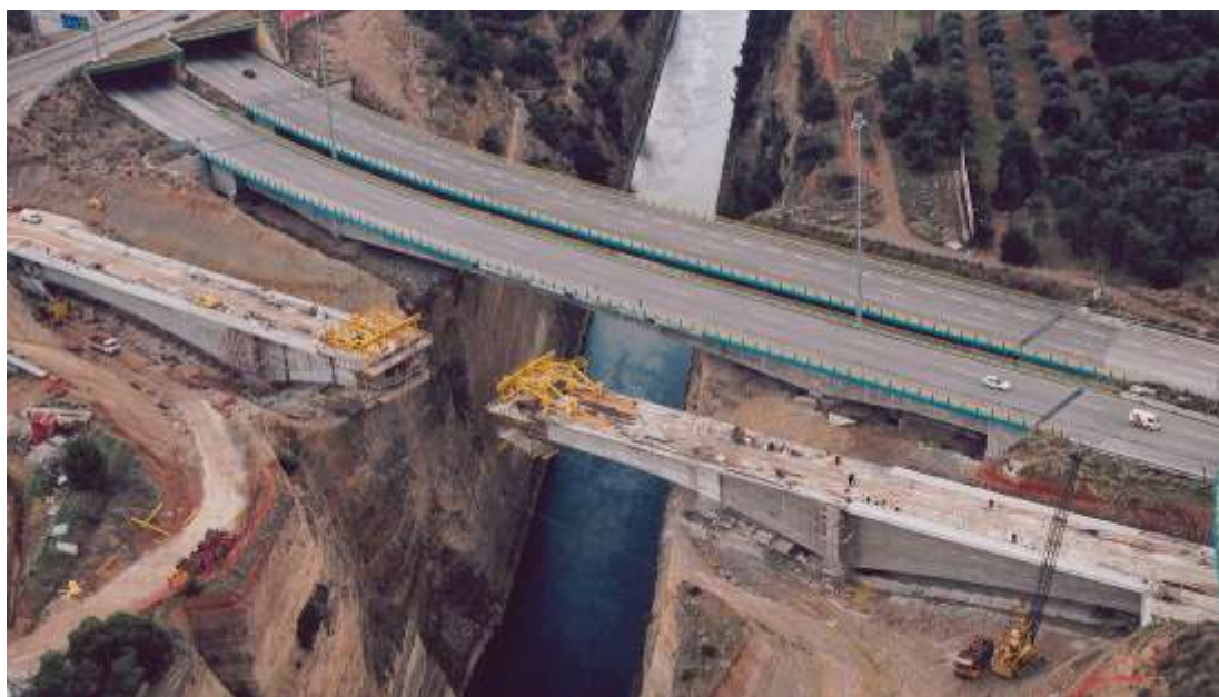
Σιδηροδρομική Γέφυρα Ισθμού: Φάση κατασκευής με προβολοδότηση
